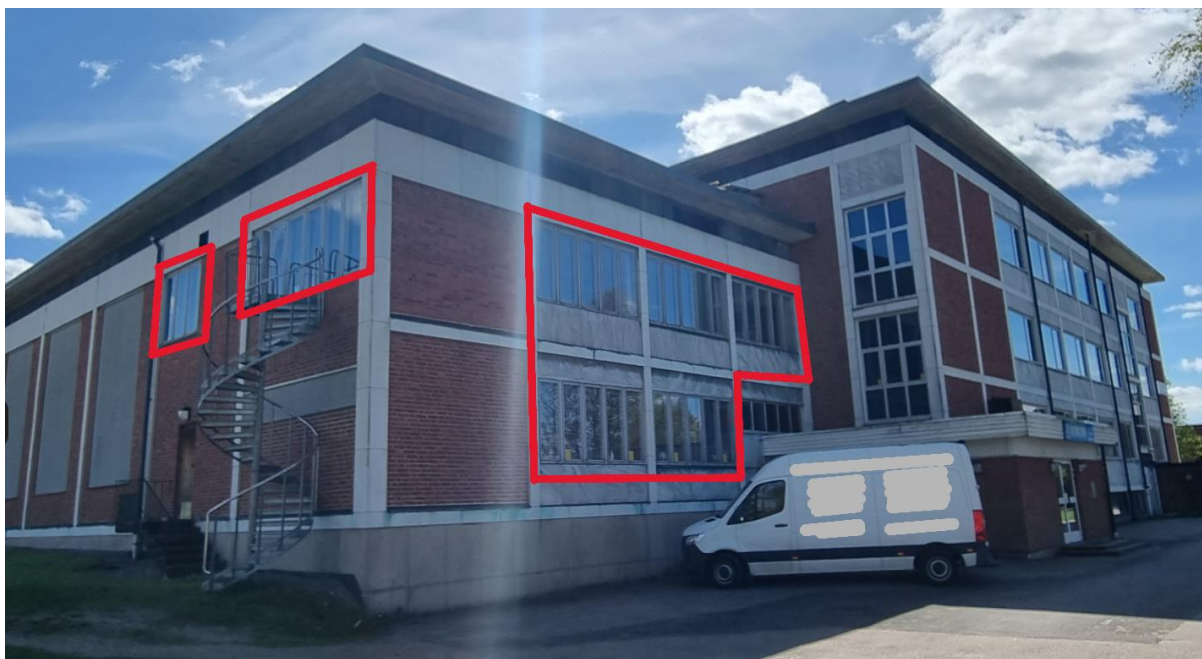
Bild 5 och 6. Inom röd markerat område på bilden ovanför visas de befintliga metallfönster med rundade hörn som ska bibehållas till sin utformning. Bild 6 till vänster visar fönsternas utformning med tråkarm på insidan.
