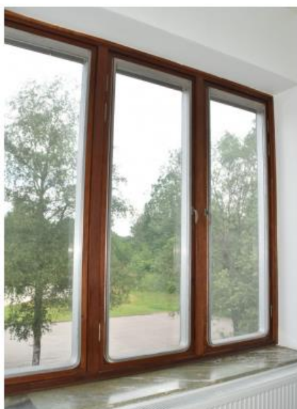
Bild 5 och 6. Inom röd markerat område på bilden ovanför visas de befintliga metallfönster med rundade hörn som ska bibehållas till sin utformning. Bild 6 till vänster visar fönsternas utformning med tråkarm på insidan.
